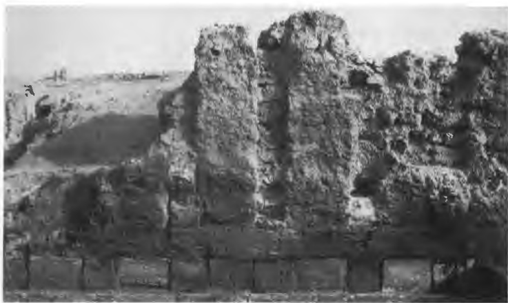
Portique ouest: poutres de l'ossature des murs carbonisées in situ.
