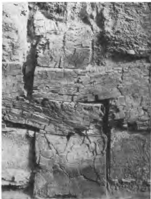
Portique ouest: poutres de l'ossature des murs carbonisées in situ.
